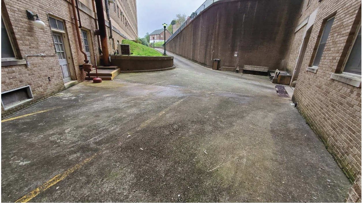
EM GENSET LAYDOWN AREA
